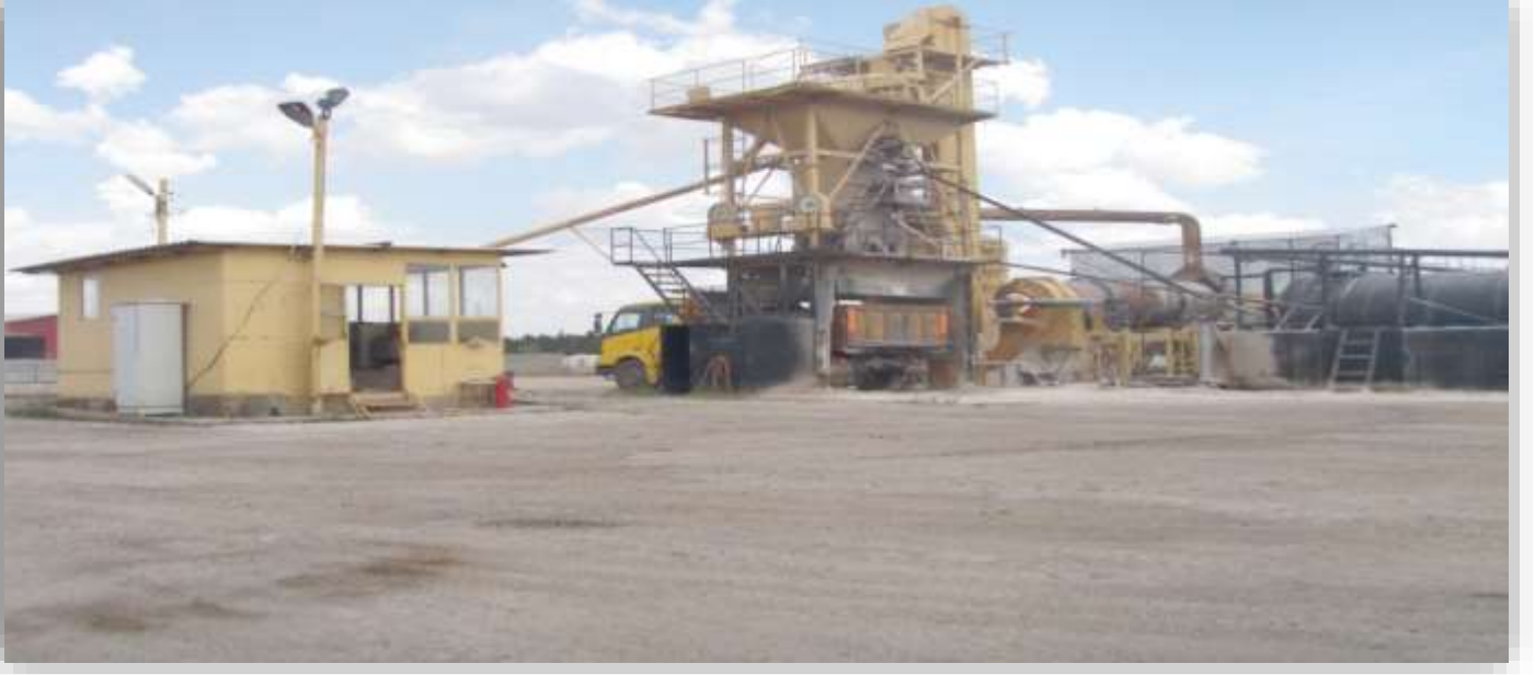
HAVSA ASFALT ŞANTİYESİ
